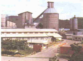
Kilang Simen di Teluk Sepanggar
