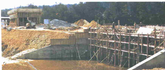
Pintu Air di Teluk Likas ini adalah sebahagian dari Skim Pengawalan banjir Kota Kinabalu. Skim yang menelan belanja $30 juta ini termasuk kerja-kerja meluaskan Sungai Inanam dan Likas, pemasangan pam air di muara sungai, parit-parit konkrit dan pintu air penghalang banjir. Projek yang sudah hampir siap ini dijangka akan dapat mengatasi masalah banjir kilat di sekitar Kota Kinabalu.
